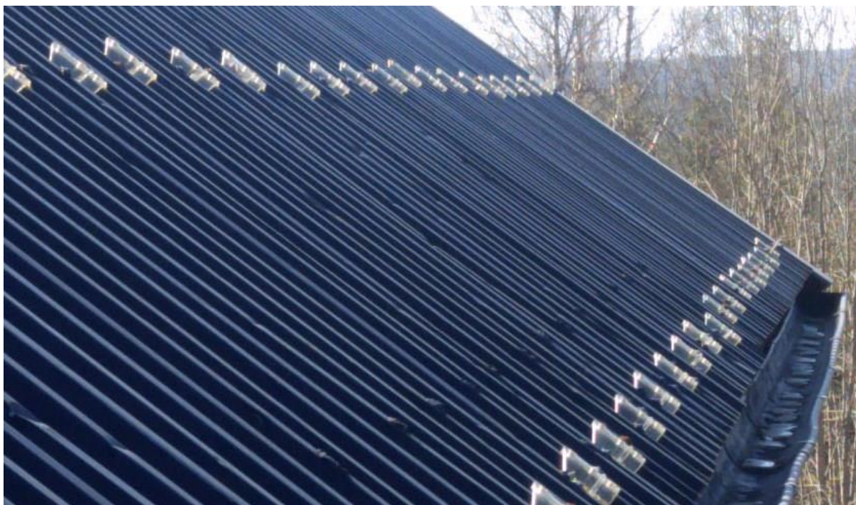
Figur 1. Tak med monterade snörasskydd.
