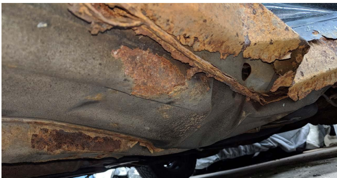
Figur 11 Golvets deformation och tröskelns yttre lager
