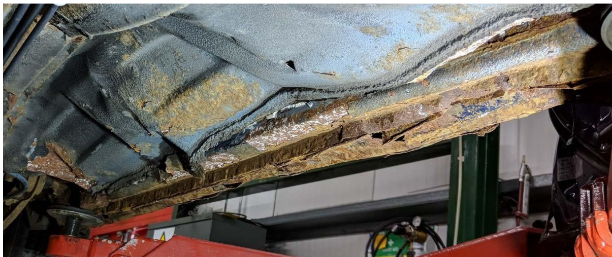
Figur 8 Omfattning av korrosionen längs med tröskeln
