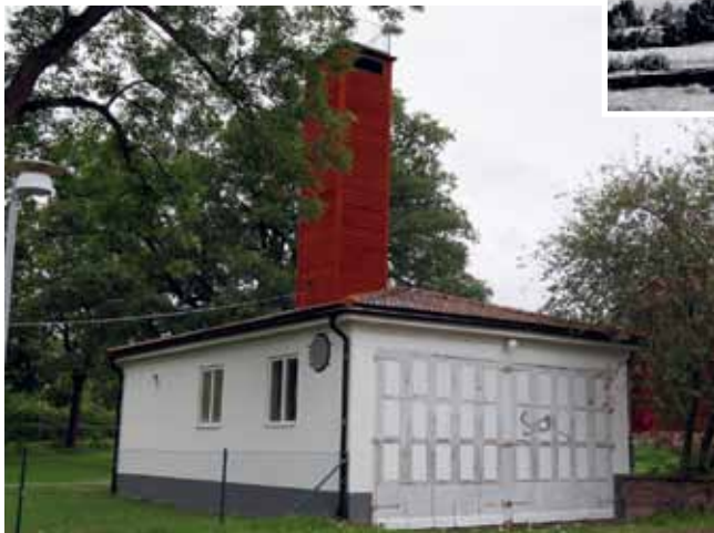
Brandstationen i Täby Kyrkby
