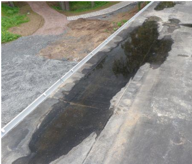
Foto 5. Ett platt tak på ett helt nytt hus där det finns stående vatten. Detta vatten kommer frysa till is vilket ger upphov till ett hårt slitage på takets tätskikt som i sin tur riskerar att gå sönder i förtid med inläckage i takkonstruktionen som följd.
