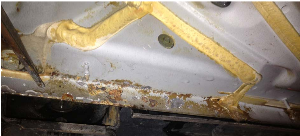
Figur 1. Korrosionsskador framträder tydligt på underredet efter demontering av plastkåporna samt rengöring. Denna bil är endast några år gammal.
